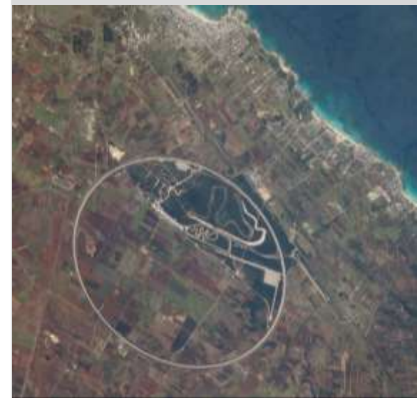
Acima, imagem aérea de um campo agrícola. Abaixo, o Nardò Ring em Nardò, Itália, construído em 1975 para testes de velocidade da Fiat, em 2012 adquirido pela Porsche Engineering.
